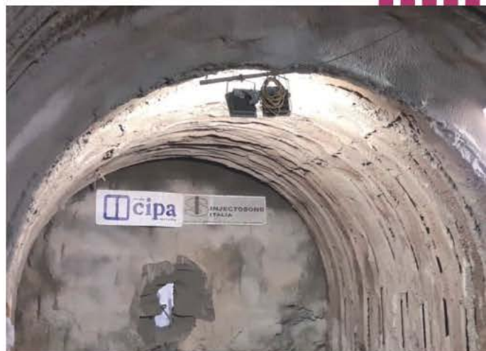
Foratura della galleria con collegamento al pozzo verticale
