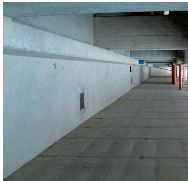
■ Parcheggio interrato del centro commerciale "CONAD SANTA CROCE" a Reggio Emilia (RE): circa 15.000 mq impermeabilizzati in presenza di falda
