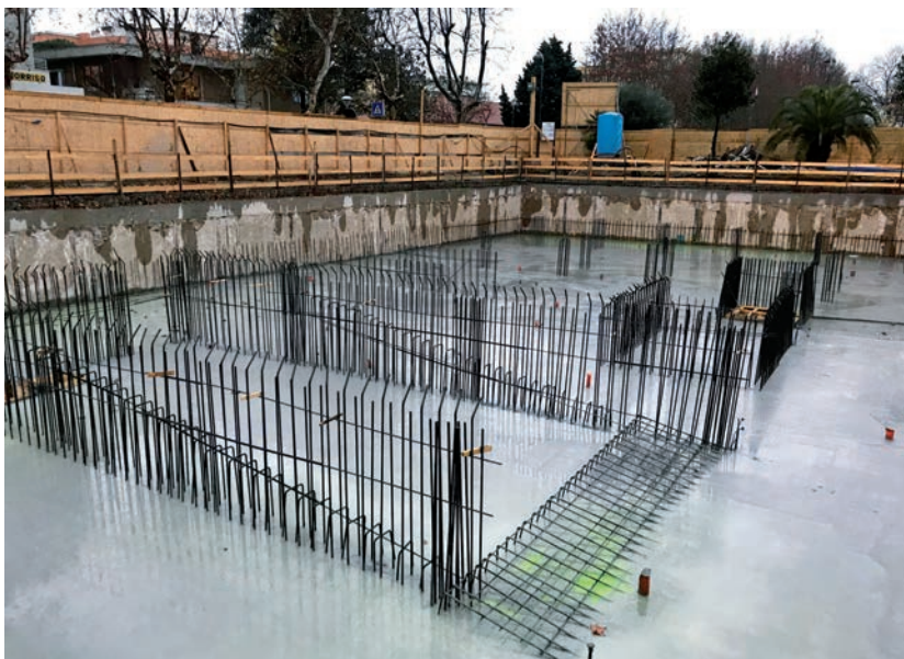
■ Nuovo edificio adibito a punto vendita CONAD e residenziale a Misano Adriatico (RN): circa 980 mc di interrato impermeabilizzati (2018). Visibile la tipica colorazione verde dell'acqua di bleeding, dovuta alla presenza di tracciante all'interno del PENETRON® ADMIX
