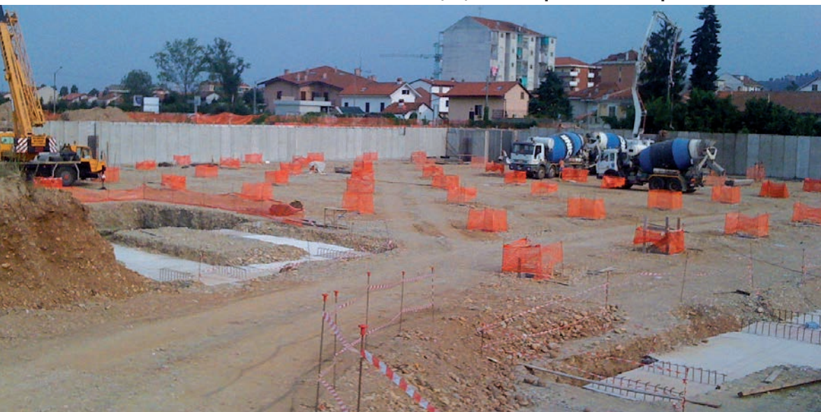
■ Centro commerciale IL GIGANTE a Chivasso (TO): 3.500 mq di interrato impermeabilizzati
