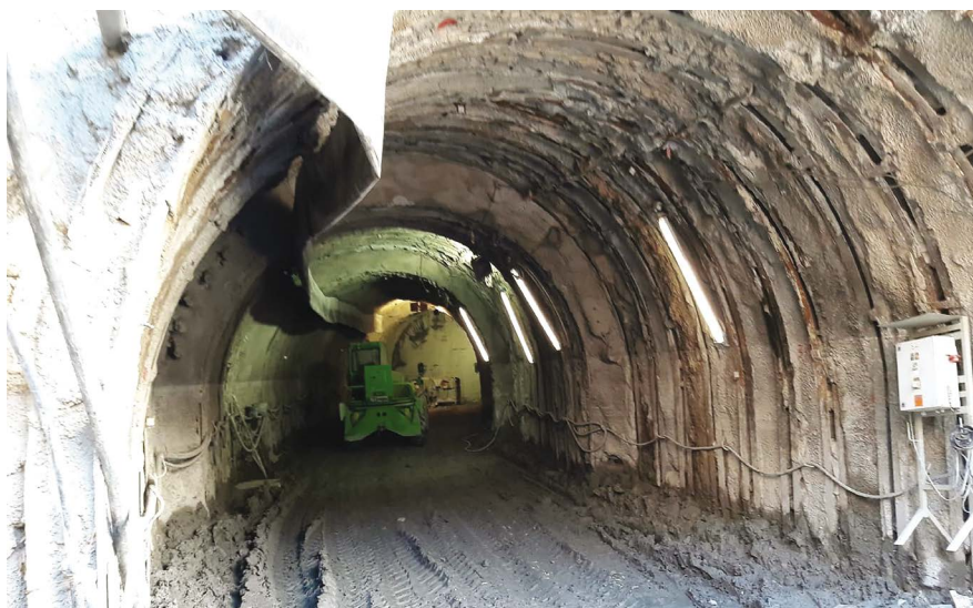
4. La galleria in calcestruzzo proiettato che collega il Padiglione 12 al Padiglione Specialità
